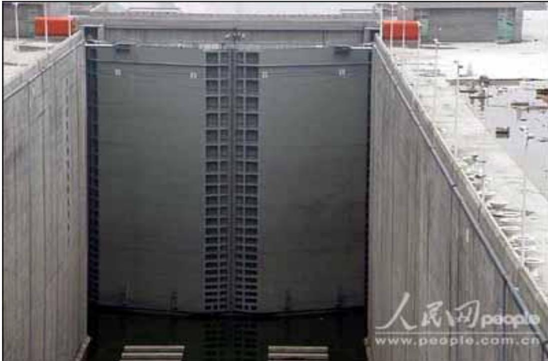
再来欣赏欣赏这个巨无霸。五级船闸共有 24 扇钢铁巨门，每扇门高 38.5 米、宽 40.4 米，厚 3 米，重达 1700 吨，相当于 4 个篮球场大。闸门呈“人”字状开启。
