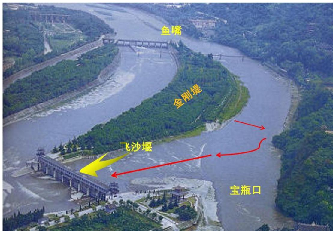
如图中红色箭头所示，洪水期内江河底的粗沙和石块就会流向河道内侧在金刚堤堆积，或从飞沙堰排向外江，据说飞沙堰能把重达千斤的巨石抛向外江。
